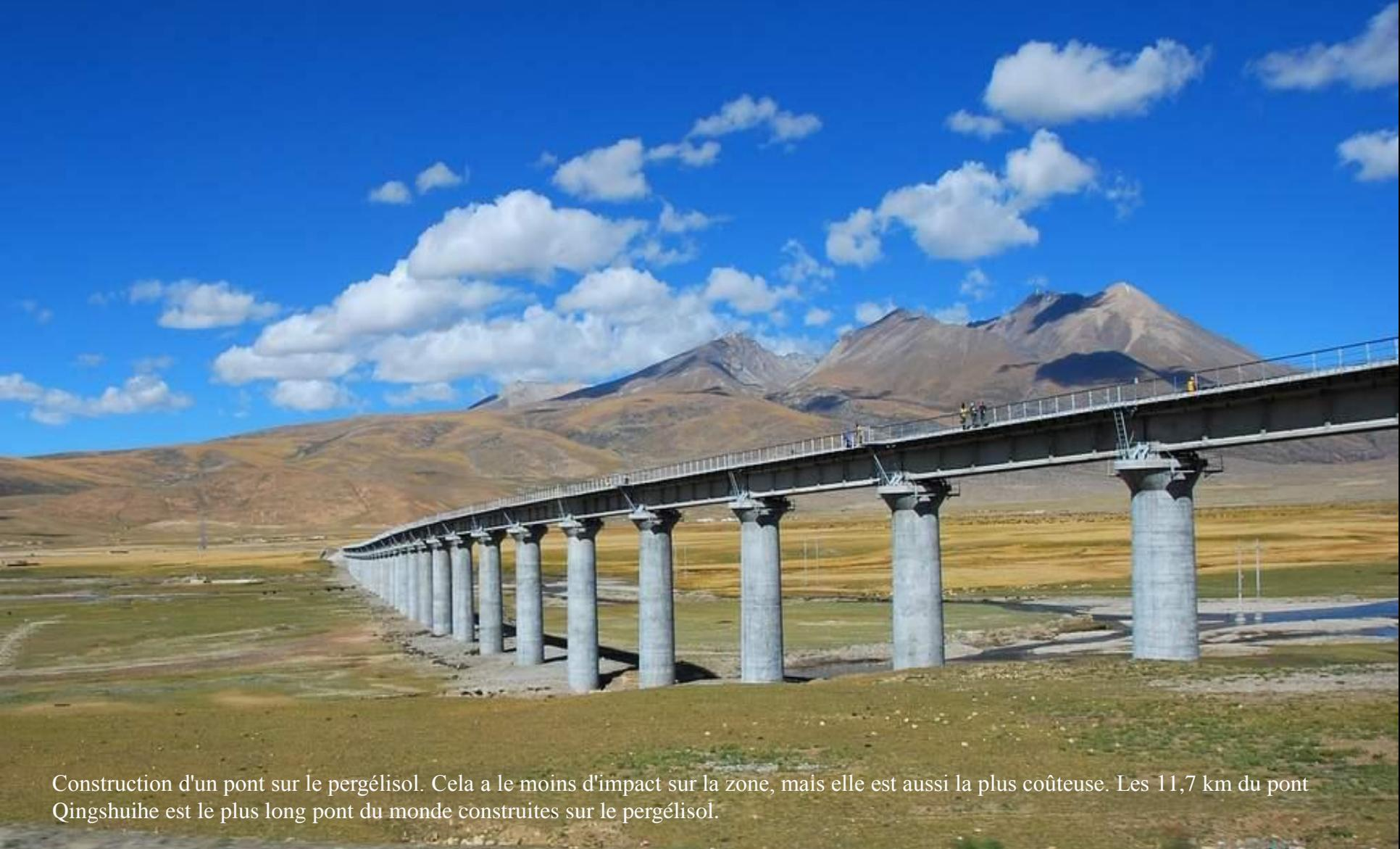
Construction d'un pont sur le pergélisol. Cela a le moins d'impact sur la zone, mais elle est aussi la plus coûteuse. Les 11,7 km du pont Qingshuihe est le plus long pont du monde construites sur le pergélisol.
