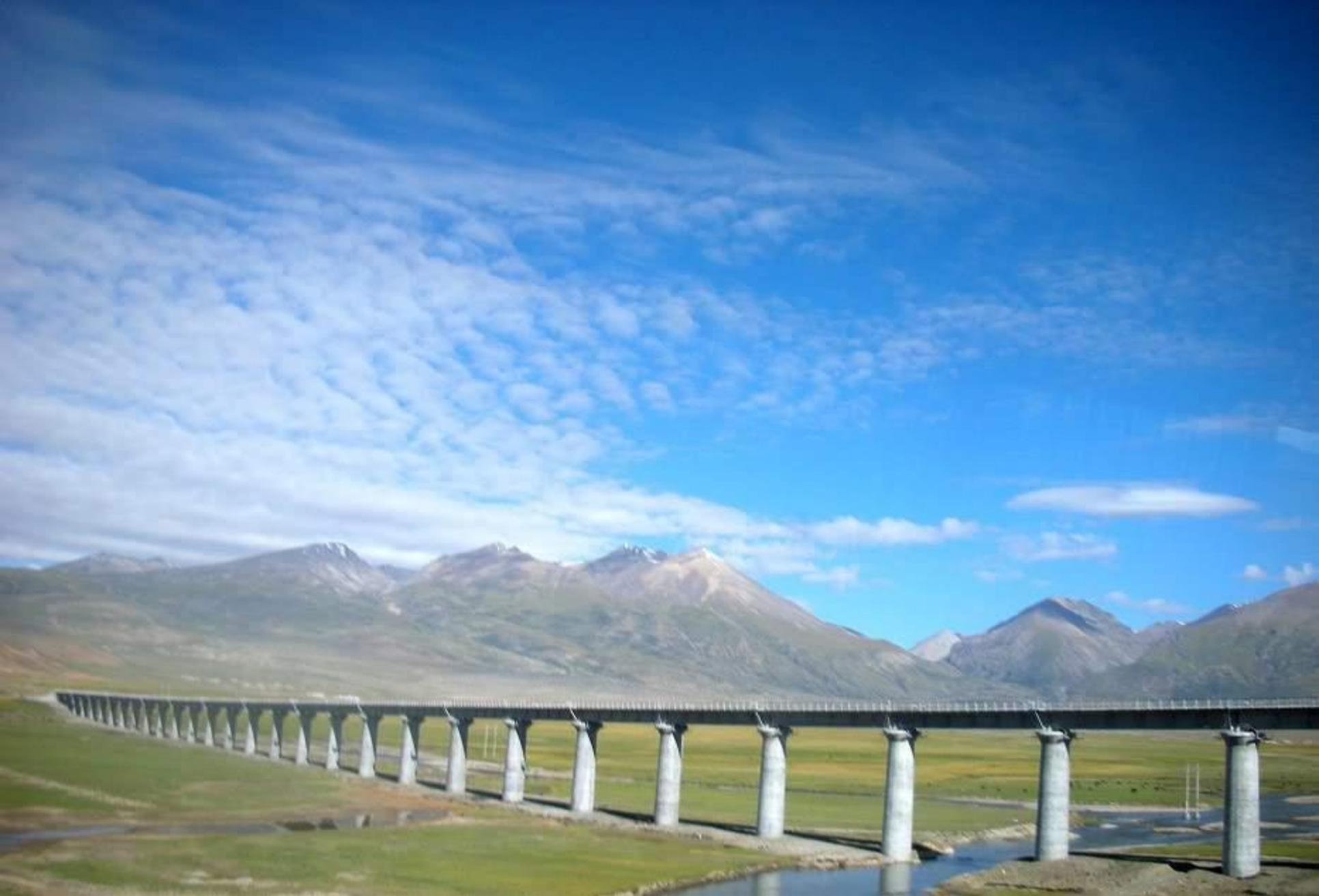
La mesure du possible, la voie ferrée est surélevée pour permettre le passage pour les espèces migratrices (par exemple, des antilopes sauvages) et de minimiser tout impact négatif sur l'environnement naturel.
